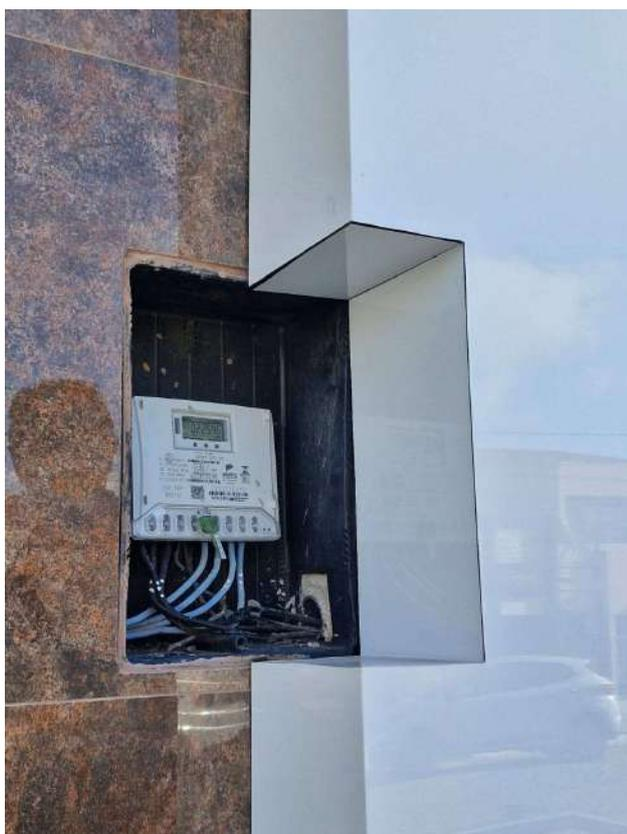
Imagem 4 – Medidor de energia instalado com fios expostos
