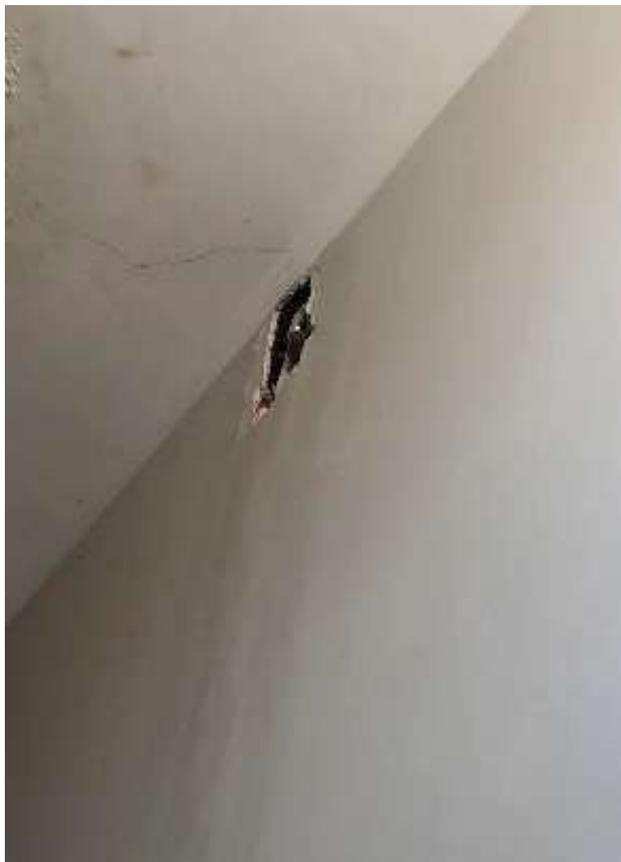
Imagem 9 – Infiltrações combinadas com perfurações, possivelmente para instalação de dutos
