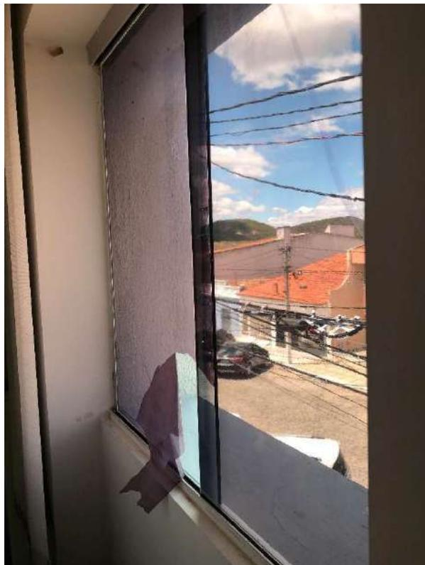
Imagem 7 – Janelas com esquadrias originais que não foram substituídas, mantendo películas antigas e desgastadas.
