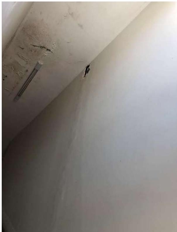
Imagem 6 – Detalhamento de infiltrações visíveis nas paredes, indicando possível falhas de vedação ou impermeabilização, além de não correção dos problemas existentes.
