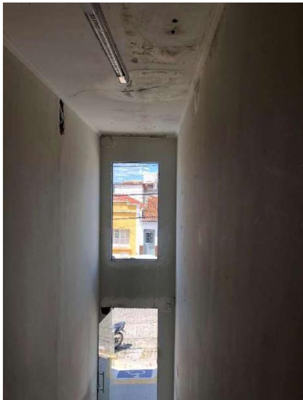
Imagem 7 – Áreas internas que permanecem sem acabamento de pintura, indicando serviço inacabado e esquadrias instaladas que não atendem às especificações previstas no projeto original
